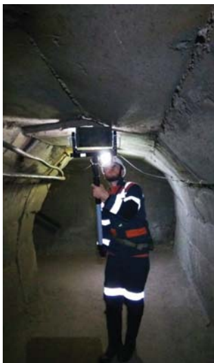
Рисунок 1 – Тестовое сканирование участков подземных горных выработок
