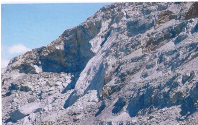
Рисунок 1 – Вид и очаг верхней части обрушения борта карьера Кумтор (8июль 2002 год).
